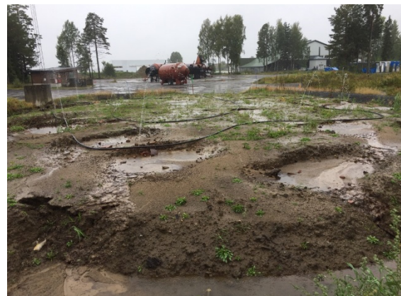
Testprosjekt med vasking av PFOS-forurensede masser
