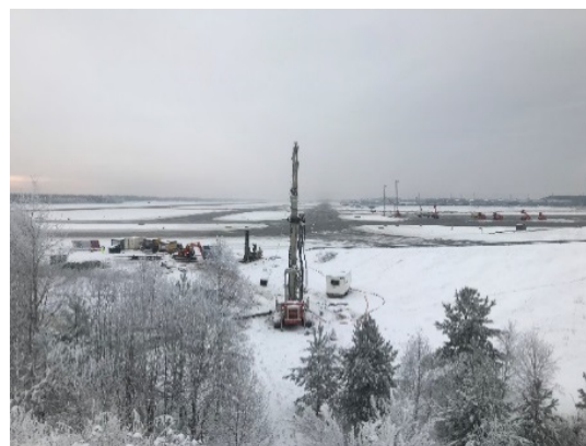
Boring etter geotermisk energi
