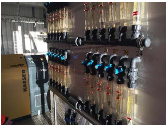
Styring av innblåsing av luft
