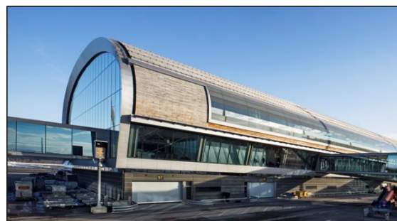
Energieffektiv form på tak i Pir Nord
