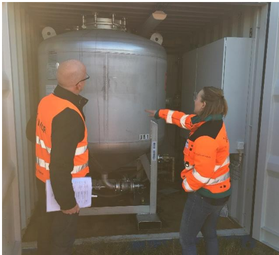
Renseanlegget for PFOS, containerløsning
