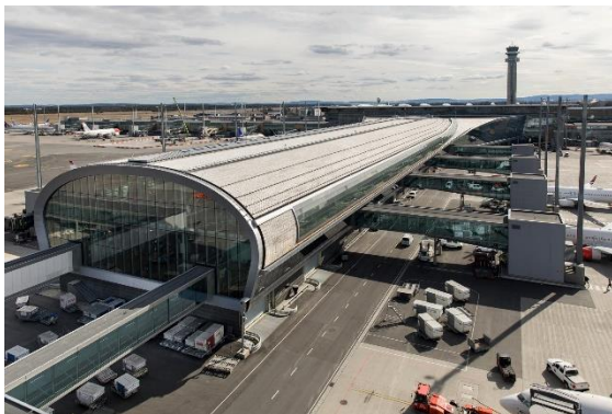
Stort behov for lademuligheter rundt på apron.
