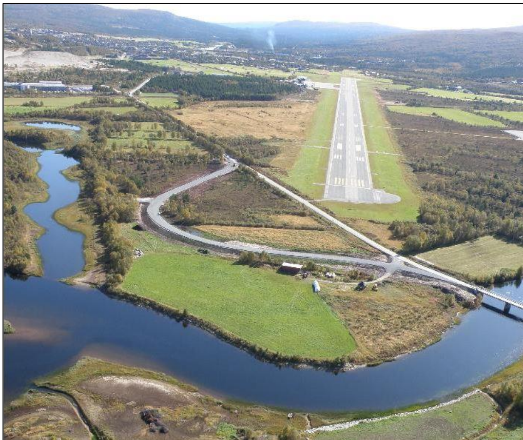
Røros lufthavn. Foto: Avinor
