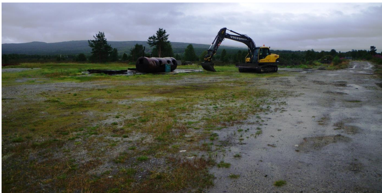
Figur 5-3. Brannøvingsfeltet sett fra landingsbanen mot sydvest (Foto: Sweco, 2012).
